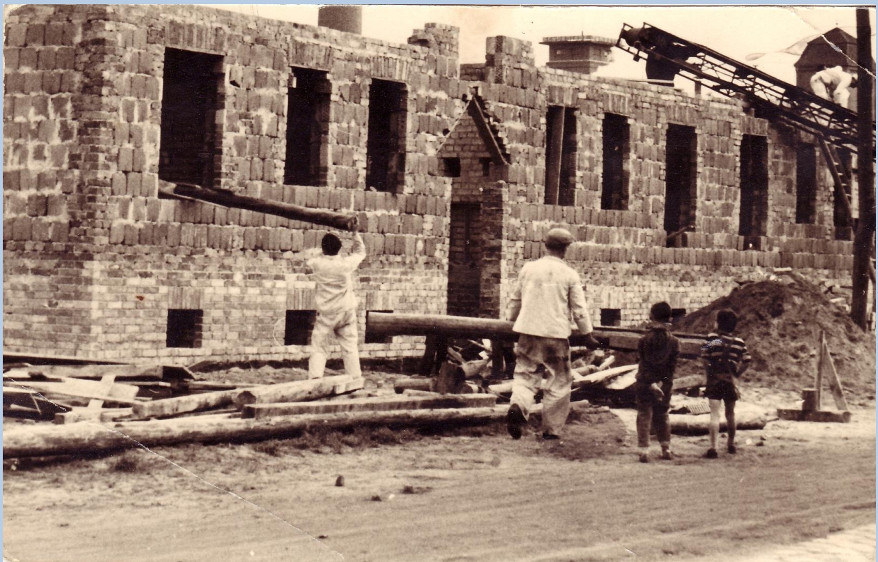
Bau der Objekte in der Friedensstraße 24a – 28b mit Eigenleistungen der damaligen Mieter
